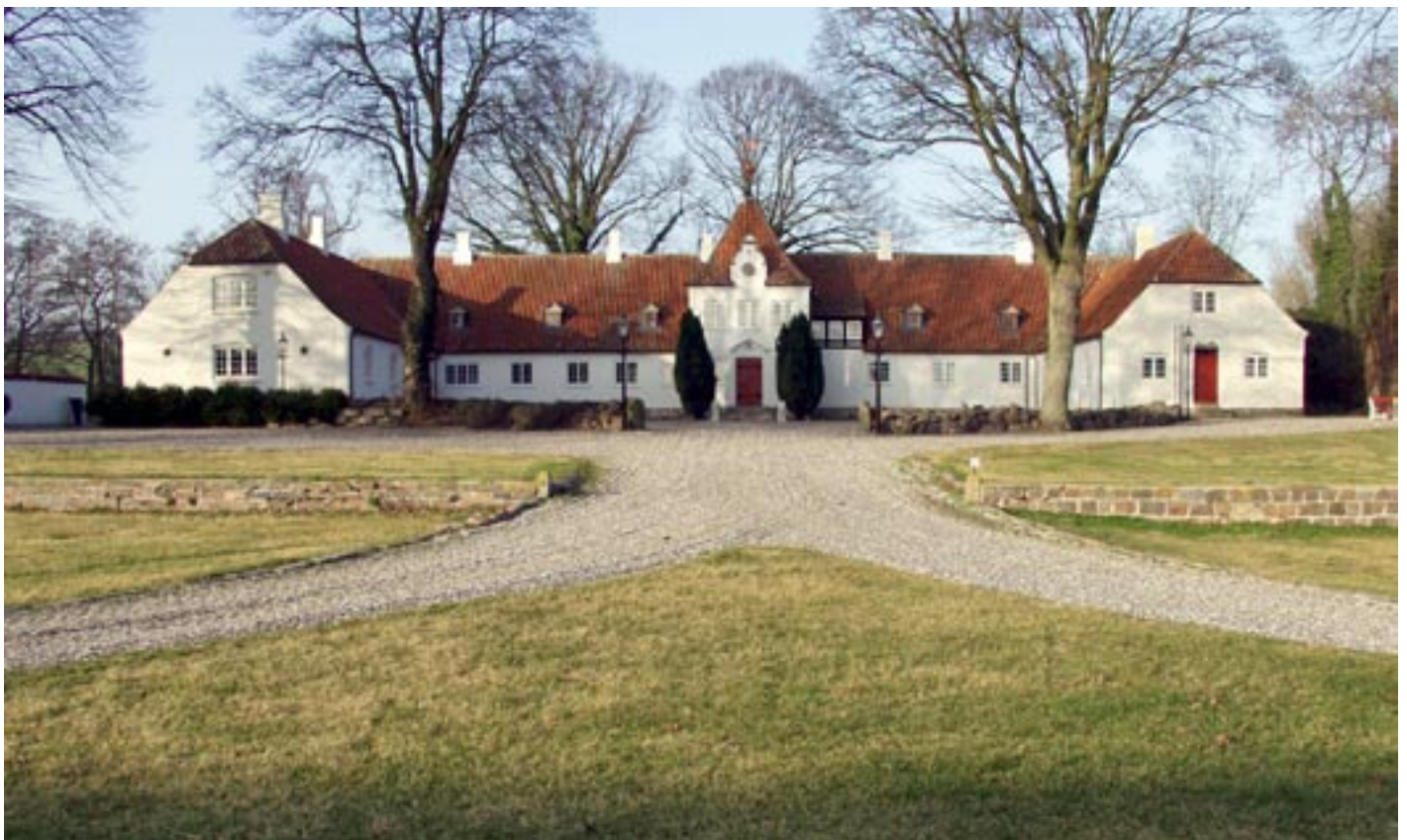
Hovedbygningen fra 1890'erne er en smuk trefløjet, grundmuret og hvidkalket bygning med tegltag.
